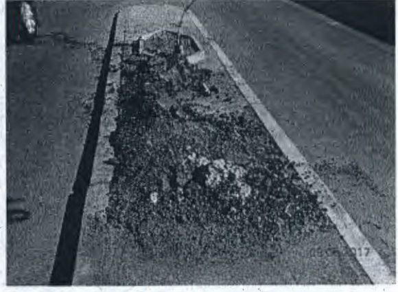
Fotografía N° 57: Escombros en la vía pública, provenientes de la ejecución de la obra, en la intersección de las calles Lastarria y Algarrobo.
