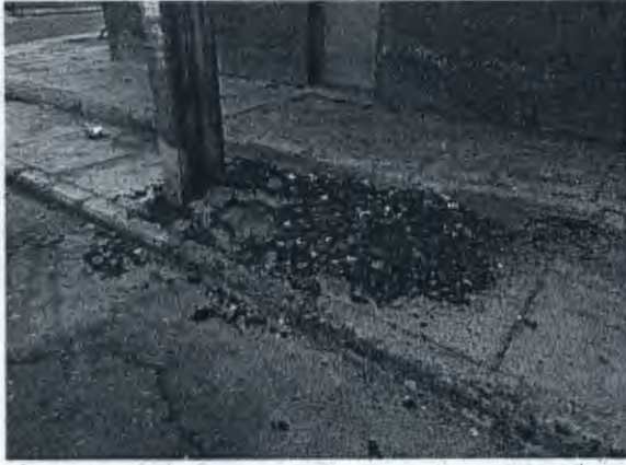
Fotografía N° 56: Escombros en la vía pública, provenientes de la ejecución de la obra, en calle Felipe Mercado, entre Libertad y Pedregal.
