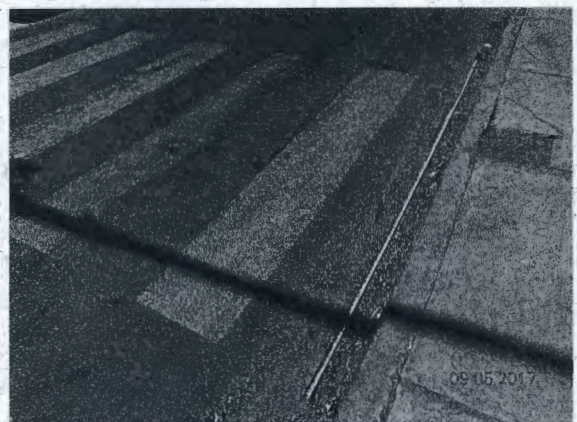
Fotografía N° 46: Medida tomada en terreno del paso de cebra ubicado en la Intersección de avenida Los Loros con Pasaje 4.
