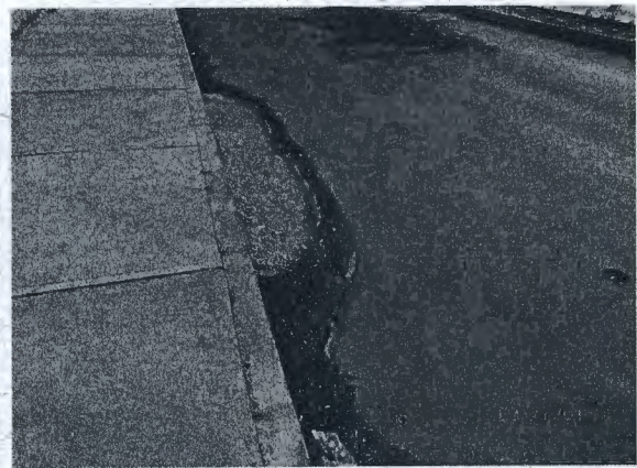
Fotografía N° 63: Material sobre calzada, en avenida Los Loros, casi al llegar a Eleuterio Ramírez.
