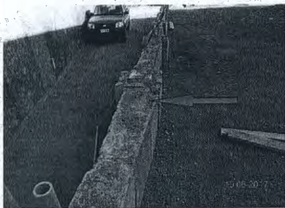
Fotografía N° 20: Deformación en muro de hormigón armado del cierre perimetral ubicado en el deslinde sur poniente de la escuela.
