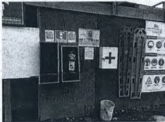
Fotografía N° 36: Extintor a la intemperie sin puerta de vidrio en su gabinete.
