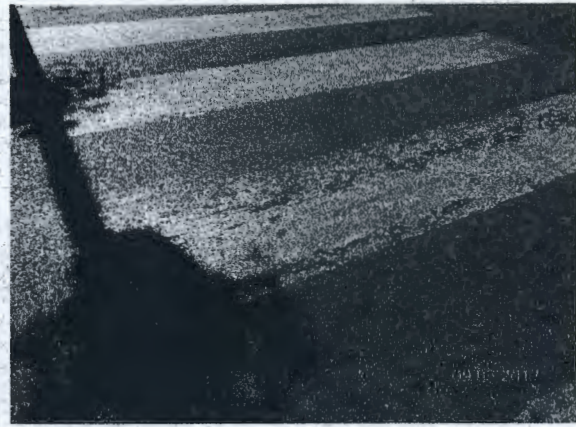
Fotografía N° 53: Franjas de paso de cebra, ubicado en avenida Los Loros con Pasaje 4, con pérdida de material.
