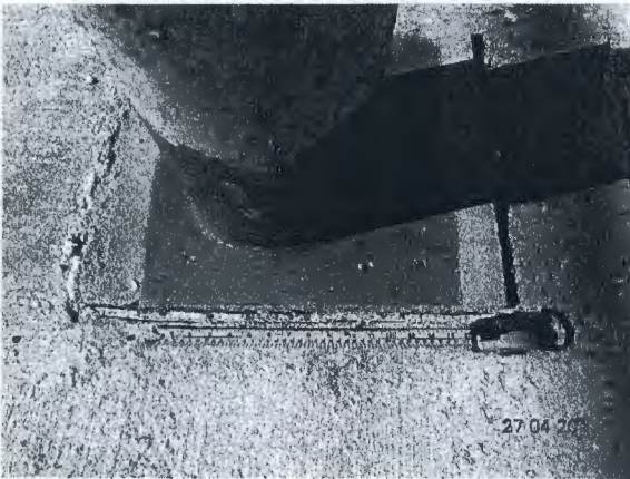
Fotografía N° 15: Placas y pernos de sujeción utilizados para la unión entre el pilar metálico y el pedestal de las fundaciones del eje G del módulo 8.
