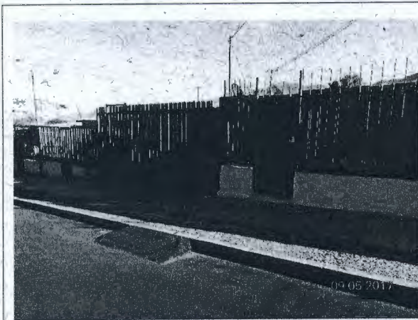
Fotografía N° 62: Material sobre calzada, en avenida Carlos Condell, entre Río Salado y Río Juncalito.
