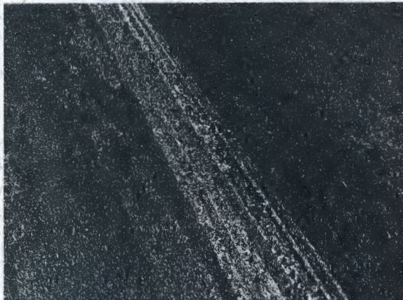
Fotografía N° 52: Sector de línea continua, ubicada en avenida Los Loros (entre las calles Eleuterio Ramírez y Villarrica), con pérdida de material.
