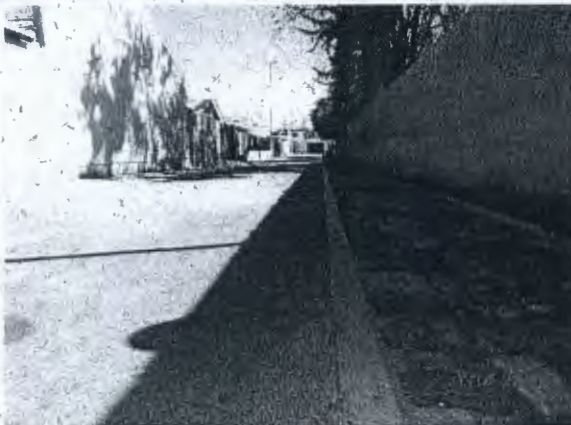
Fotografía N° 58: Soleras rebajadas que se encuentran prácticamente al mismo nivel del borde del pavimento, en pasaje José Ramelli.
