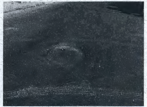
Fotografía N° 10: Tapa de cámara de inspección que no se encuentran a nivel con la rasante del pavimento, en la intersección de Licancabur con Copahue.
