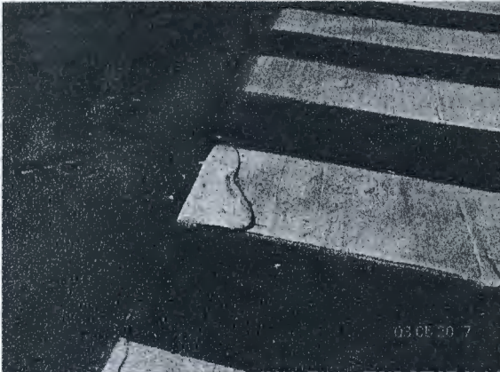
Fotografía N° 21: Deficiente terminación en paso de cebra.
