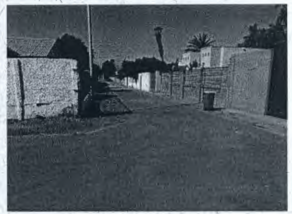
Fotografía N° 59: Soleras rebajadas que se encuentran prácticamente al mismo nivel del borde del pavimento, intersección entre pasajes María Figari y Gemma Saltori.
