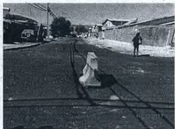
Fotografía N° 61: Barrera articulada que incumple la norma, ubicada en la intersección del callejón Pedro León Gallo con calle Pedro Lira.
