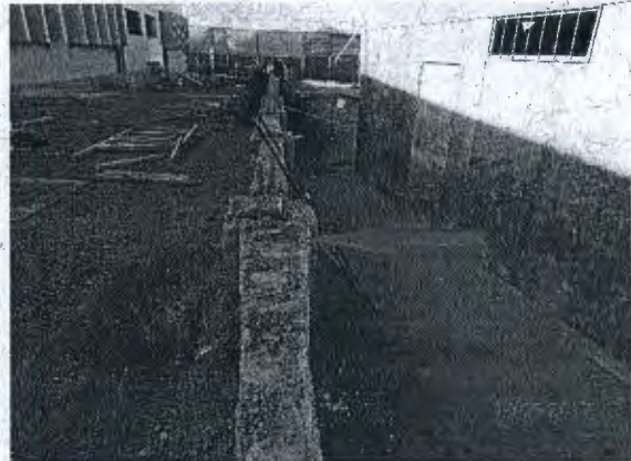
Fotografía N° 21: Deformación en muro de hormigón armado del cierre perimetral ubicado en el deslinde sur poniente de la escuela.
