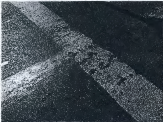
Fotografía N° 54: Líneas de detención frente al paso de cebra, ubicado en avenida Los Loros con Pasaje 4, con pérdida de material.
