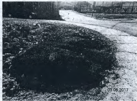
Fotografía N° 55: Escombros en la vía pública, provenientes de la ejecución de la obra, en avenida El Chañar con Manganita.
