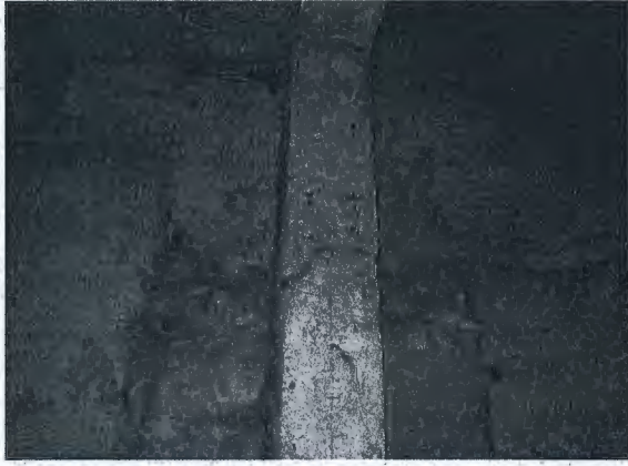
Fotografía N° 13: Nido en machón ubicado bajo las graderías del anfiteatro (subterráneo del módulo 10), en la intersección de los ejes 4 y A.
