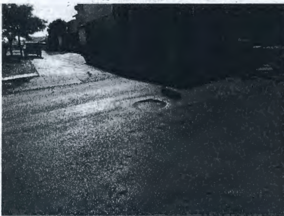
Fotografía N° 11: Tapa de cámara de inspección que no se encuentran a nivel con la rasante del pavimento, en la intersección de Licancabur con Tupungato.
