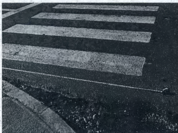
Fotografía N° 48: Medida tomada en terreno del paso de cebra ubicado en la Intersección de Miguel Gallo con avenida Lastarrias.
