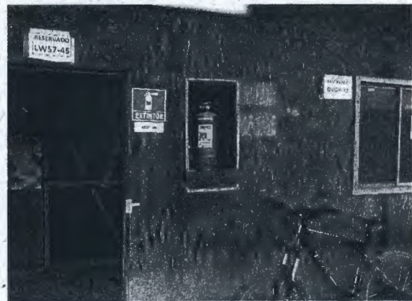
Fotografía N° 37: Extintor a la intemperie sin puerta de vidrio en su gabinete.
