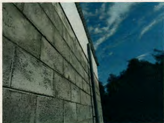
Fotografía N° 27: Tubería de ventilación instalada en vivienda de GSA.
