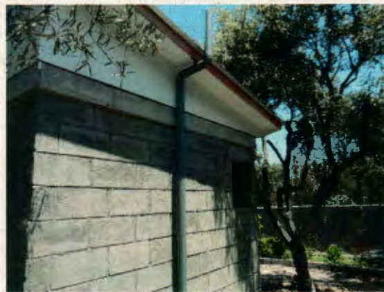
Fotografía N° 30: Tubería de ventilación instalada en vivienda de JVF.
