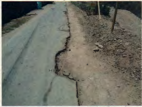
Fotografía N° 70: Ausencia de señalización vial en tramo intervenido.
