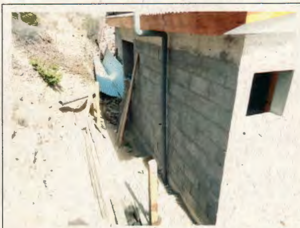
Fotografía N° 25: Tubería de ventilación instalada en vivienda de EPG.
