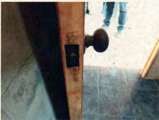
Fotografía N° 23: Puertas instaladas, caseta sanitaria beneficiario GSA.
