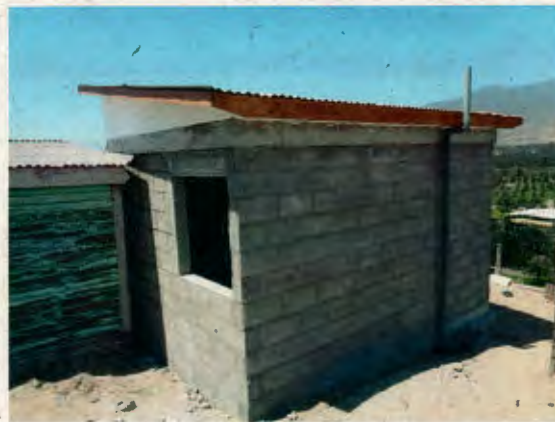
Fotografía N° 28: Tubería de ventilación instalada en vivienda de DVZ.
