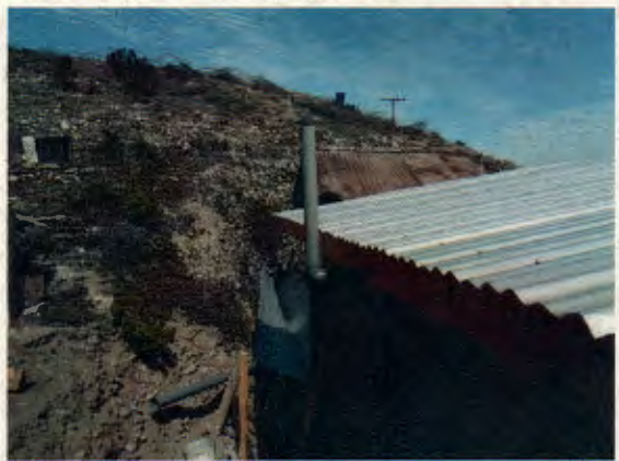
Fotografía N° 24: Tubería de ventilación instalada en vivienda de EPG.
