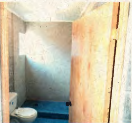
Fotografía N° 22: Puertas instaladas, caseta sanitaria beneficiario GSA.
