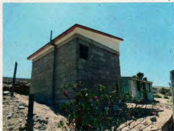
Fotografía N° 29: Tubería de ventilación instalada en vivienda de DVZ.
