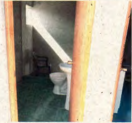
Fotografía N° 20: Puertas instaladas, caseta sanitaria beneficiaria EPG.
