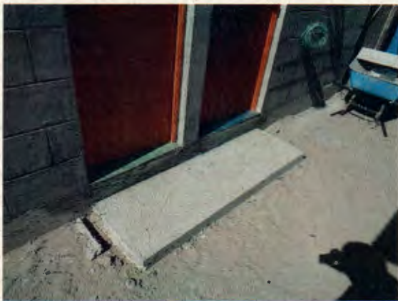
Fotografía N° 21: Puertas instaladas, caseta sanitaria beneficiaria EPG.
