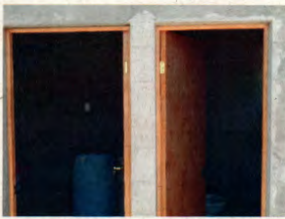
Fotografía N° 19: Puertas instaladas, caseta sanitaria beneficiaria MSV.
