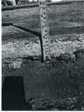
Fotografía N° 49: Entrada de vehículo en calle Club de Leones, con acera de espesor 7 cm (vinculada a fotografía N° 48).
