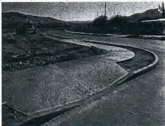
Fotografía N° 20: Acera ejecutada, intersección calle Club de Leones con calle 5.
