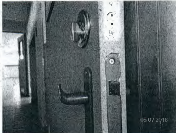
Fotografía N° 48: Cerradura de puertas interiores marca Poli.
