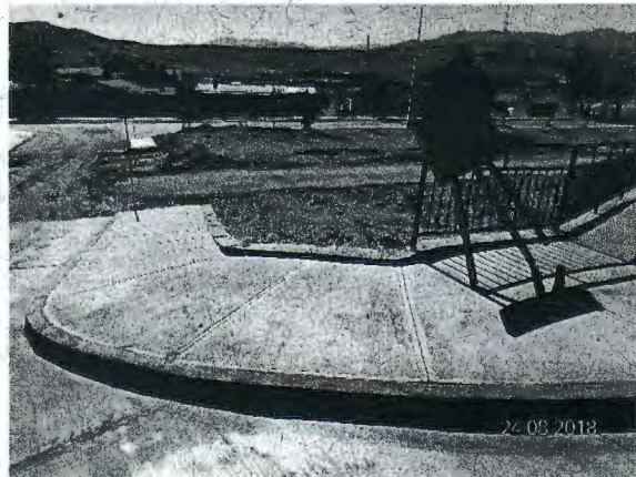
Fotografía N° 30: Acera ejecutada, intersección calle Hernán Aravena con calle 3.
