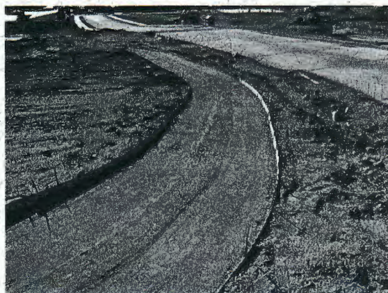
Fotografía N° 17: Acera en ejecución, intersección calle Hernán Aravena con calle 5.
