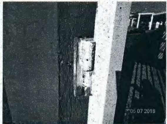
Fotografía N° 4: Mala terminación en pintura de portón metálico de la salida (intersección de las calles Ejército Libertados e Isla Nueva).
