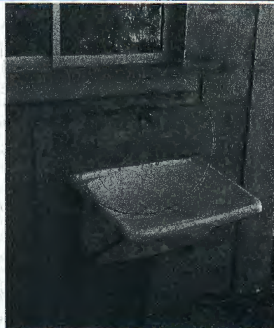
Fotografía N° 14: Falta de espejuelo en zona de lavadero. Caseta sanitaria 4, MZ "C".
