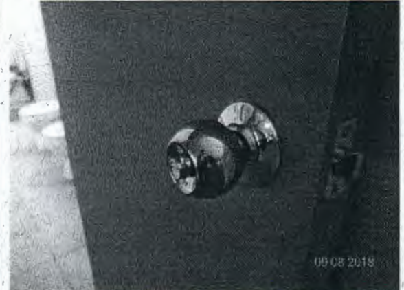
Fotografía N° 70: Cerradura con seguro interior, en puerta de sala de hábitos higiénicos.
