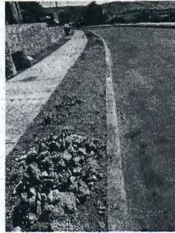
Fotografía N° 34: Restos de escombros.
