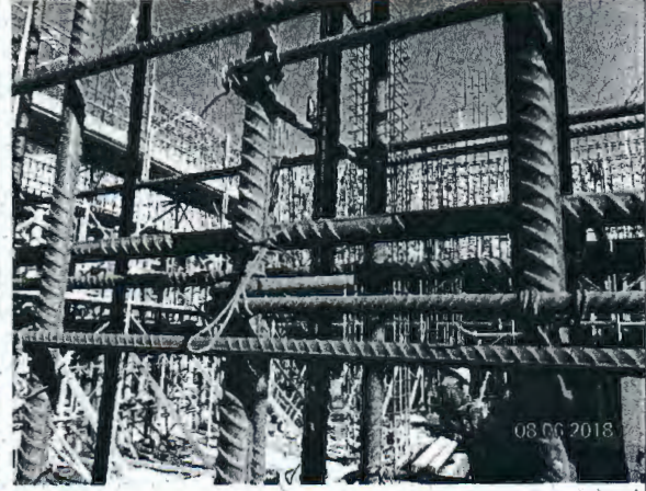
Fotografía N° 14: Enfierraduras montadas con presencia de óxido.
