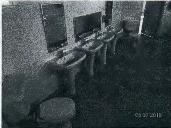
Fotografía N° 39: Sala de mudas y hábitos higiénicos del módulo "D" no cuenta con un lavamanos para adultos.
