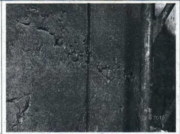
Fotografía N° 10: Nido en el muro del eje A del sector de graderías.
