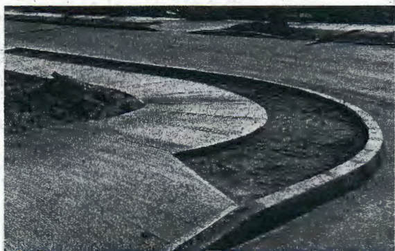
Fotografía N° 21: Acera ejecutada, intersección calle Club de Leones con calle 5.
