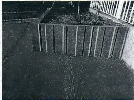
Fotografía N° 2: Muro de hormigón del cierre perimetral teñido con color rojo utilizado en las aceras.
