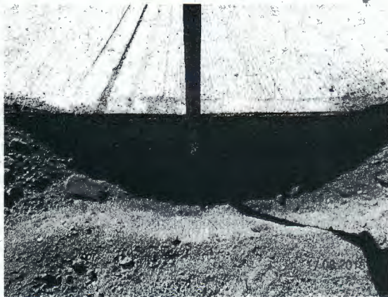
Fotografía N° 53: Entrada de vehículo en calle Hernán Aravena, con acera de espesor 7 cm (vinculada a fotografía N° 52).
