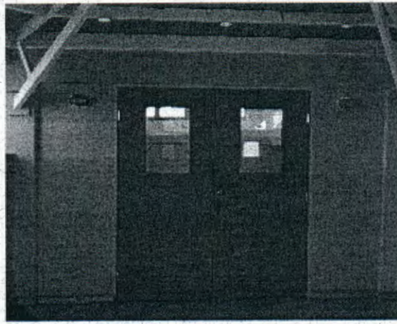
Fotografía N° 72: Puertas sin un sistema de sujeción que permita mantenerlas abiertas en situaciones de evacuación.
