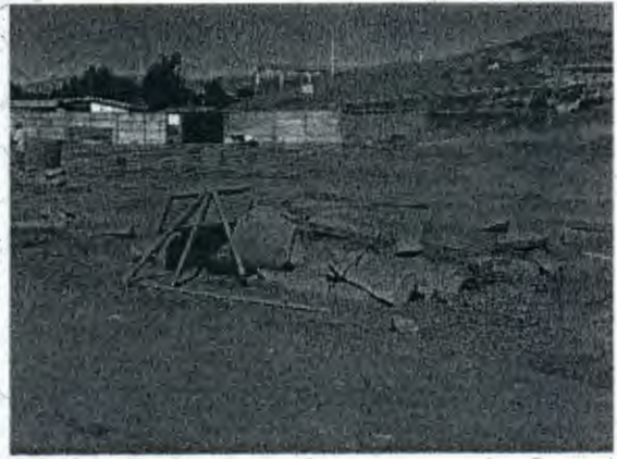
Fotografía N° 32: Restos de materiales y escombros.
