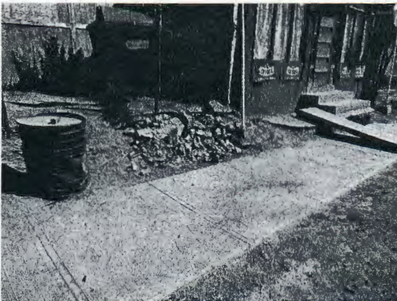
Fotografía N° 35: Restos de escombros.
