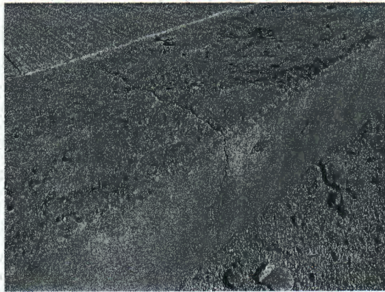
Fotografía N° 63: Fisuras en murete y muro de mampostería, a lo largo de toda la calle Hernán Aravena y calle 2.
