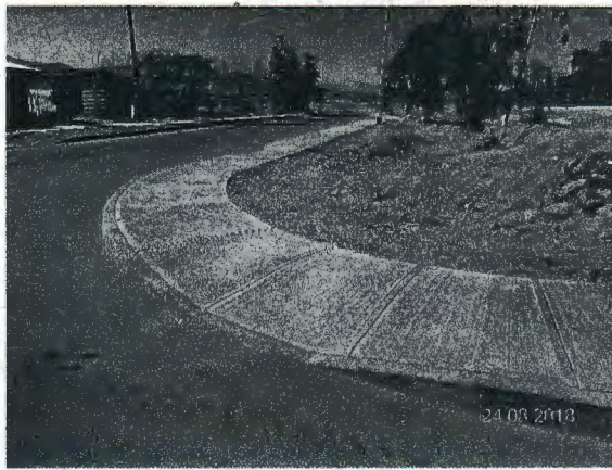
Fotografía N° 27: Acera ejecutada, intersección calle Club de Leones con calle 3.
