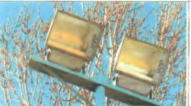
Ilustración 8: Luminaria Existente, proyector haluro metálico.
