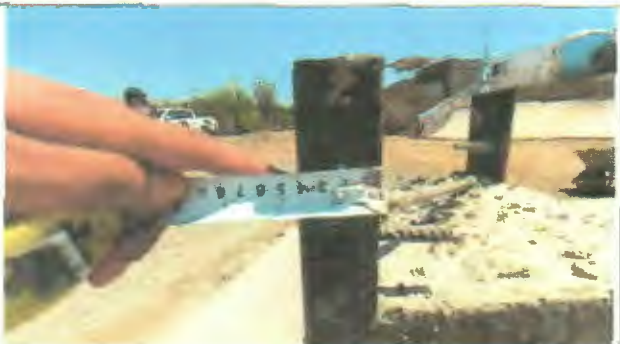
Ilustración 31: Perfil ángulo 40x40x3mm en muros verticales.
