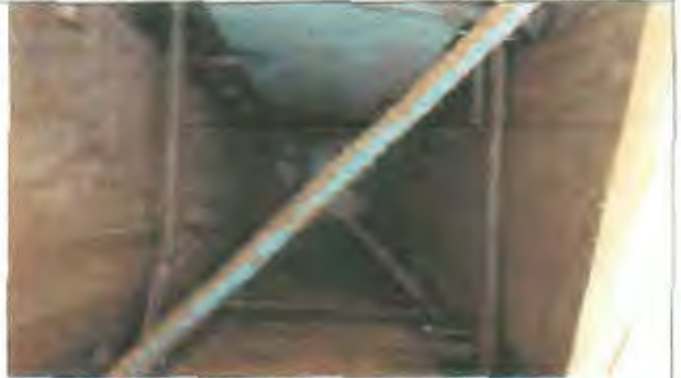
Ilustración 28: Arreglos de soldadura, con perfil ángulo en cantos a hormigonar, y espárragos para fijación de ambos elementos.
