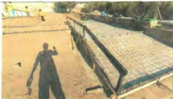
Ilustración 38: Perfil cuadrado 50x50x3mm, en pilares de barandas 100x50.
