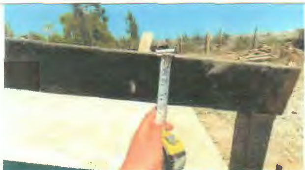
Ilustración 37: Perfil cuadrado 50x50x3mm, en pilares de barandas 100x50.
