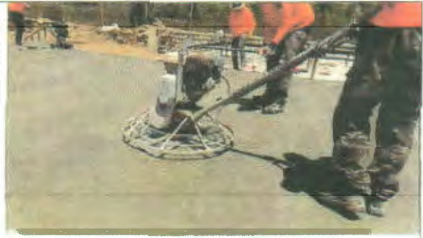
Ilustración 11: Pulido de hormigón Skatepark Valenar.
