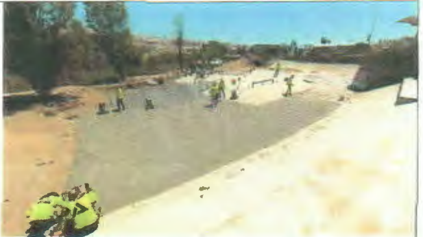
Ilustración 15: Proceso pulido de hormigón - Skatepark Valenar.
