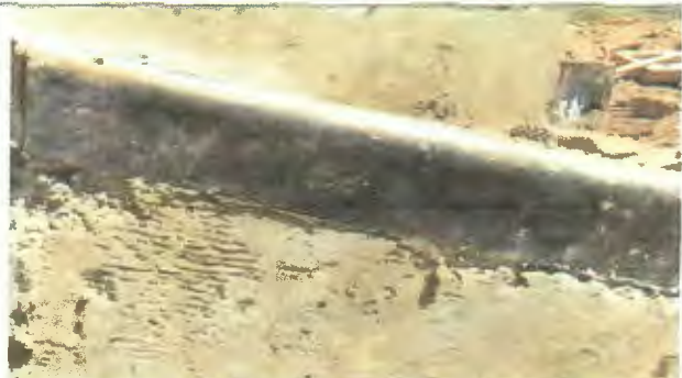
Ilustración 29: Perfil ángulo 40x40x3mm en muros con pendiente.
