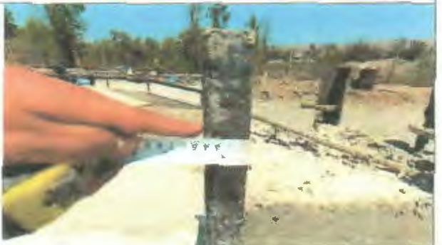
Ilustración 30: Perfil ángulo 40x40x3mm en muros verticales.
