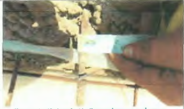
Ilustración 42: Instalación Barras de traspaso de carga.
