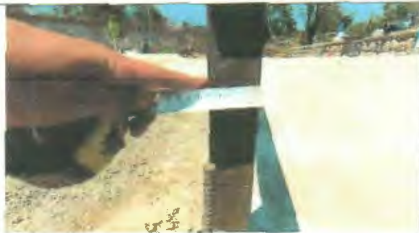
Ilustración 36: Perfil cuadrado 50x50x3mm, en pilares de barandas 100x50.
