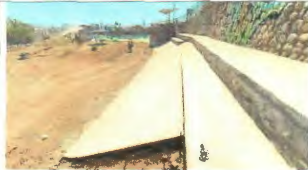
Ilustración 27: Terminación con hormigón, Perfil C 100x50x3mm, con espárragos.
