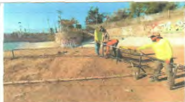
Ilustración 33: Instalación de barandas deslizables.
