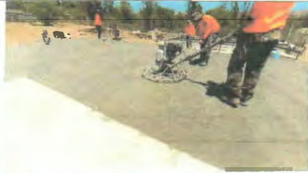
Ilustración 10: Pulido de hormigón Skatepark Valenar.
