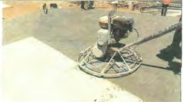
Ilustración 13: Pulido de hormigón Skatepark Valenar.
