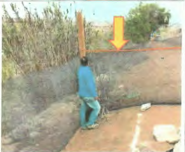
Ilustración 5: Altura de rellenos y defensa fluvial - muro de contención proyectado, sector más desfavorable.
