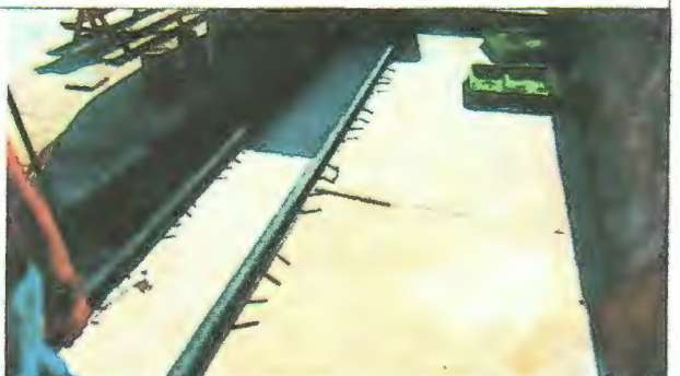
Ilustración 24: Preparación de Perfil C 100x50x3mm, con espárragos.
