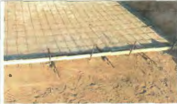
Ilustración 41: Instalación Barras de traspaso de carga.
